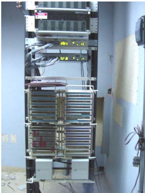
Figura 1.3.1 Arreglo de un IDF
