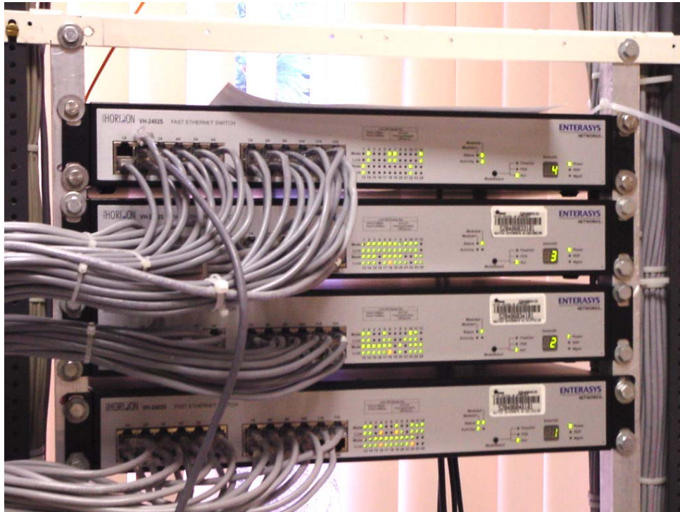
Figura 1.3.3 Salidas de los switches a las diferentes PC's
