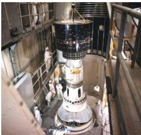
Figura 3.7.7.2 Satélite Meteorológico GOES-C que está siendo introducido a bordo de un cohete Delta [23].
