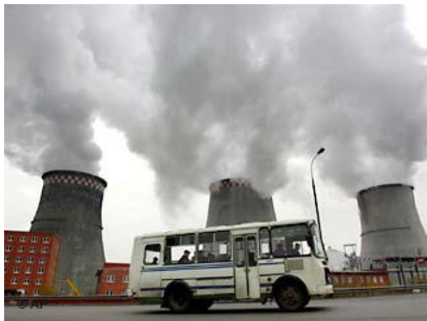
2.2 Contaminación ambiental en las afueras de Moscú. Rusia firmó el Protocolo de Kioto.
