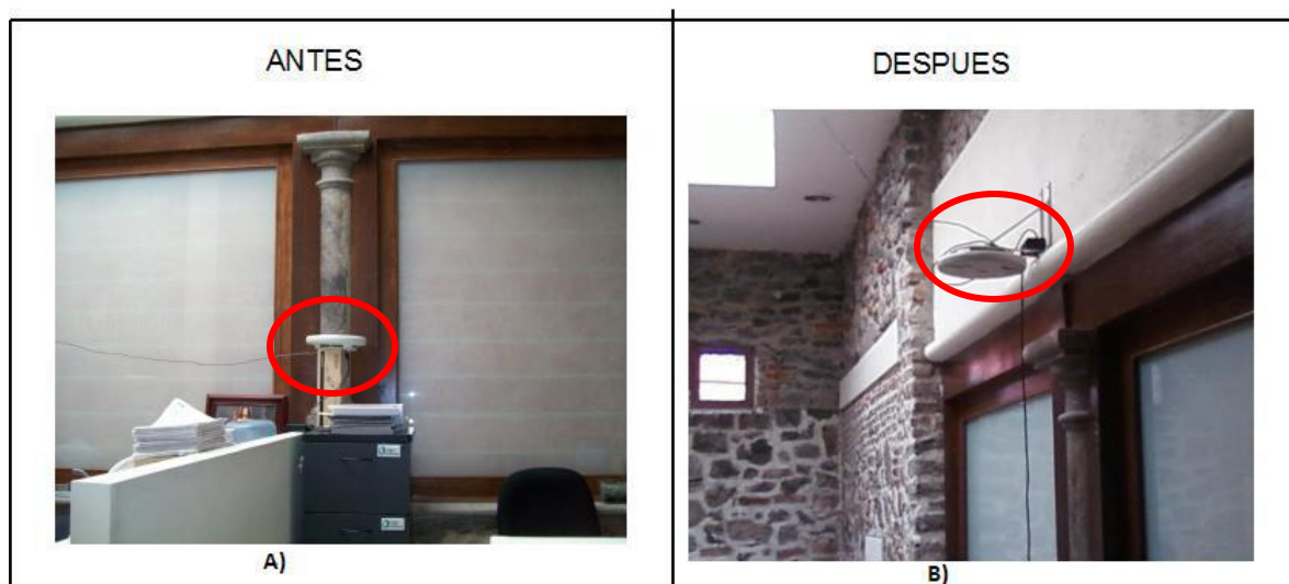
Figura 3.3.7 Reubicación de Xirrus 2. A) Realizando pruebas de cobertura. B) Xirrus 2 fijo.
