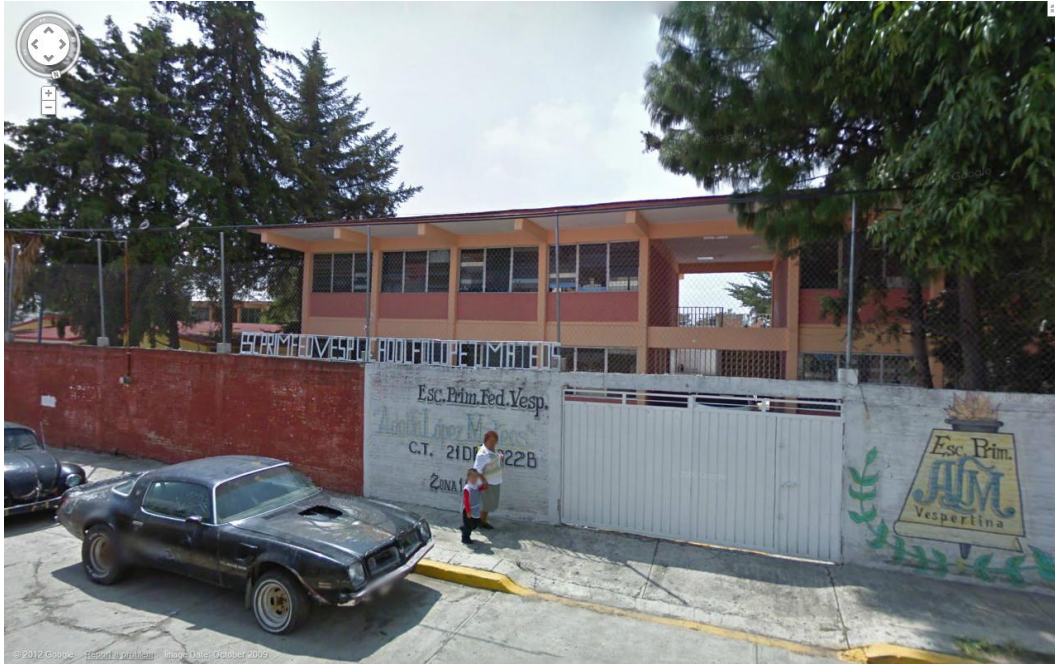
Imagen 5 Fachada de la Escuela Primaria Federal Vespertina “Licenciado Adolfo López Mateos”
